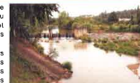
Seuil du Fresquel vu depuis le pont de la RD.203 Source : BRL
